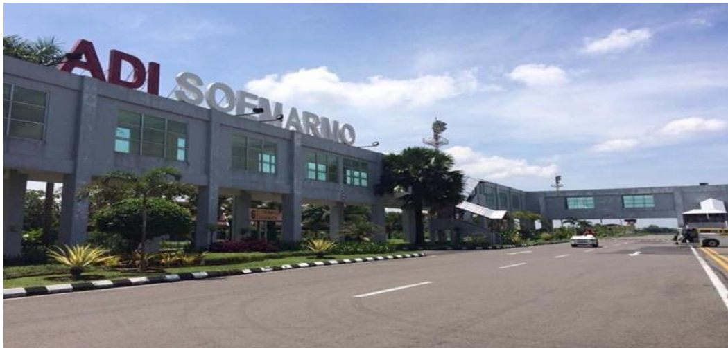
Gambar 2. 2 Bandar Udara Internasional Adisumarmo Surakarta
